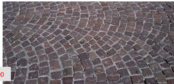
Blocchetti in porfido posati a raggiera
