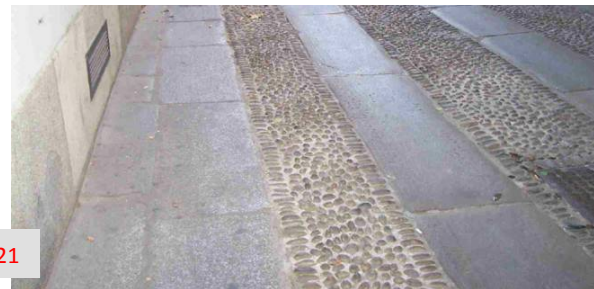
Lastre laterali in granito carrozzabili ed acciottolato centrale
