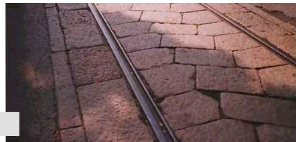
Pavimentazione in granito asimmetrico con laterali catramati
