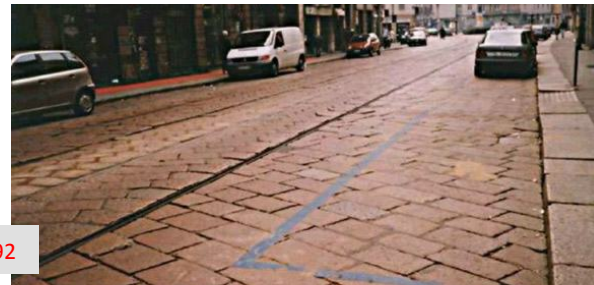
Pavimentazione completa in granito asimmetrico
